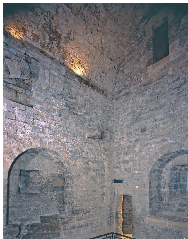
Fig. 8 Vue intérieure de l'angle sud-ouest du 2e étage.
