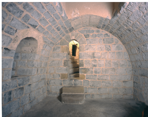
Fig. 5 Vue d'ensemble du rez-de-chaussée.
