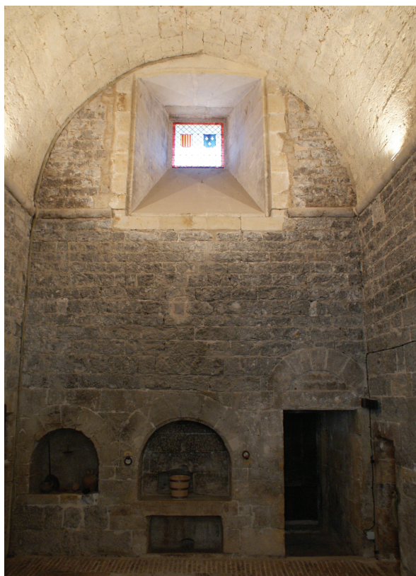
Fig. 7 Élévation intérieure nord du 1er étage.
