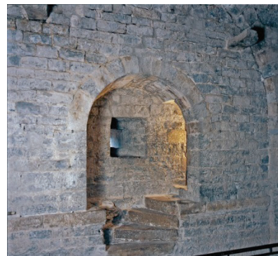
Fig. 12 Niche du 2e étage desservant l'escalier en vis.
